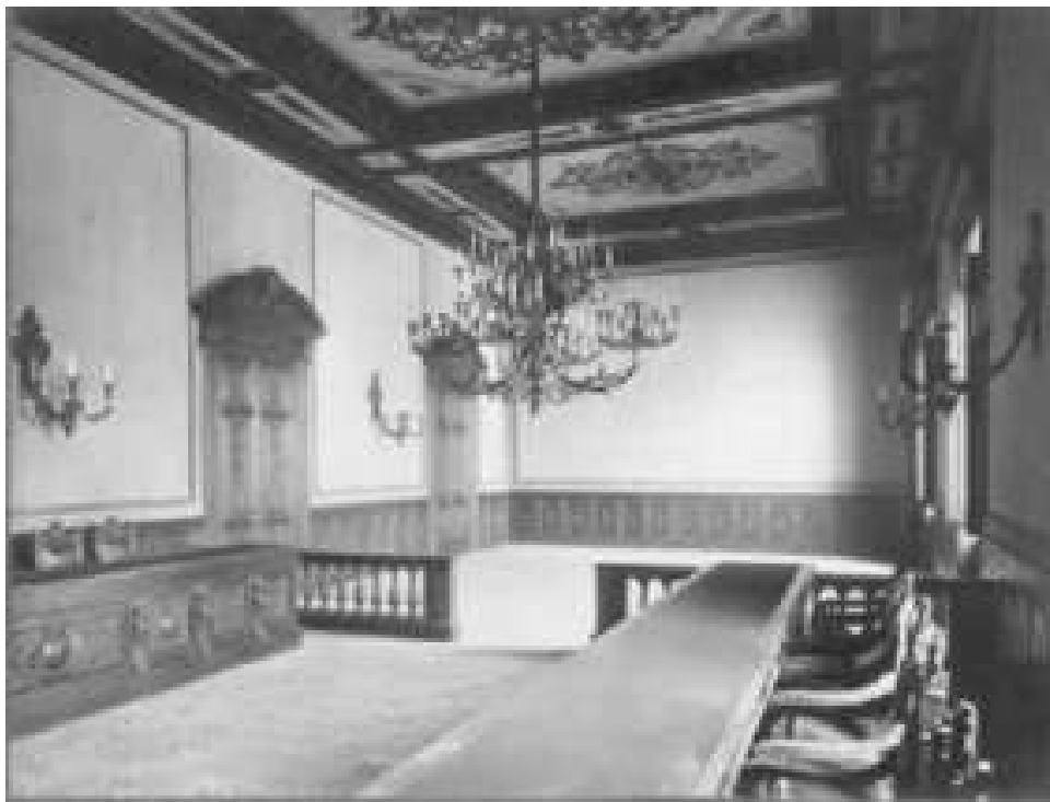
In alto, la Sala del Consiglio (foto d'epoca), in basso, i resti della struttura originaria al piano terra.
