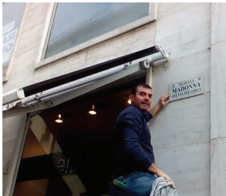
sopra: un momento della posa in opera della ceramica effettuata dal capomastro Alessio Sforza
